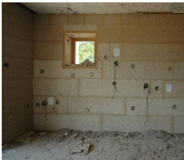
Abbildung 20: Einbau der Messsonden
