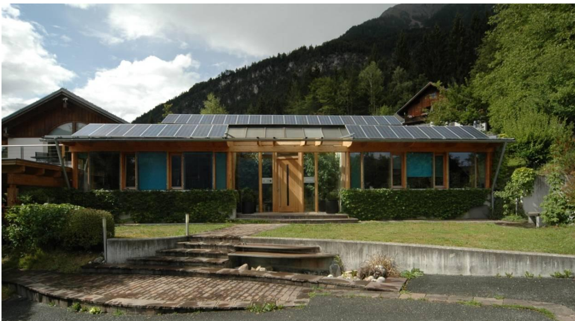
Abbildung 67: PV-Anlage 4 auf dem Dach des Architekturbüros Ronacher – Foto von Süden
