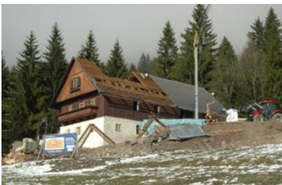
Abbildung 3: Abbrucharbeiten des alten Dachstuhles
