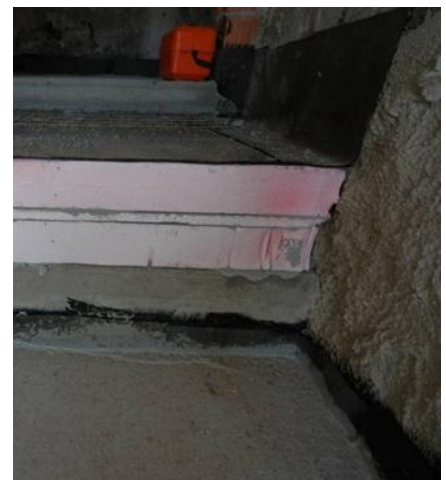
Abbildung 14: 30 cm Innendämmung
