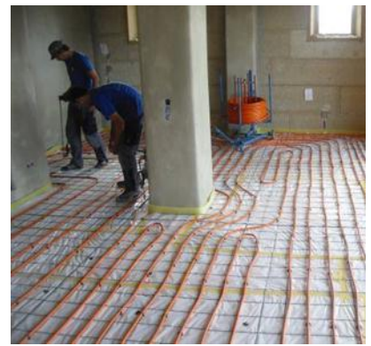
Abbildung 44: Fußbodenheizung im EG Verlegungsarbeiten
