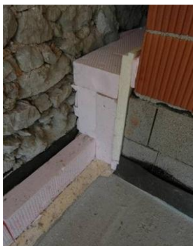
Abbildung 12: Fußbodendämmung 24 cm XPS Platten unterhalb des Unterbetons
