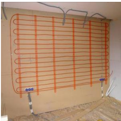
Abbildung 42: Wandheizung vor Aufbringen des Lehmputzes
