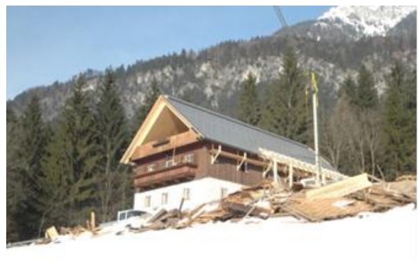
Abbildung 5: neuer Dachstuhl samt neuer Dachdeckung
