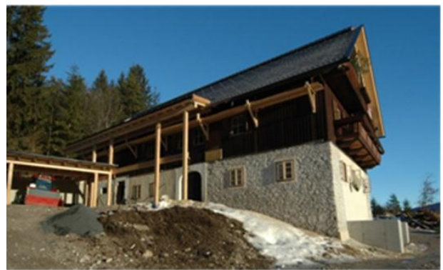
Abbildung 4: Baustellenfoto, Außenputz abgeschl., neues Dach
