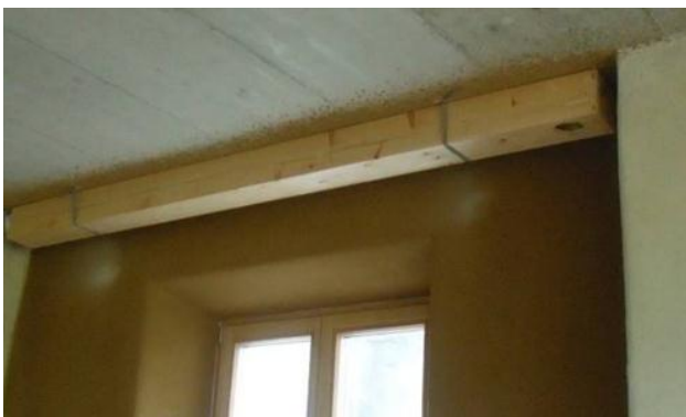
Abbildung 47: Zirbenholzkanal an der Decke des EG
