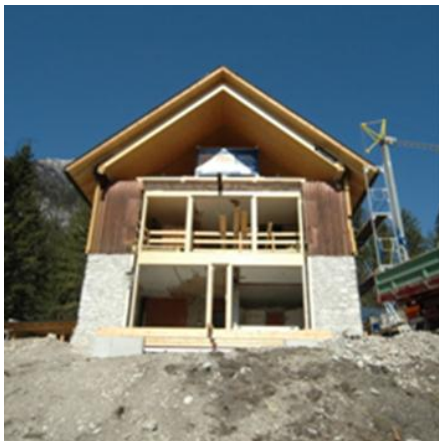
Abbildung 6: Öffnung der Südfront
