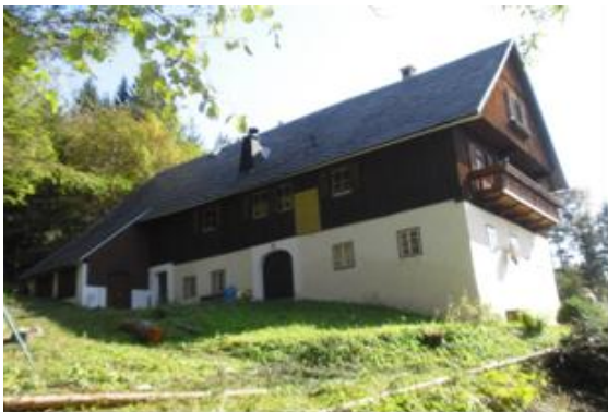
Abbildung 2: Altbestand vor Beginn der Baumaßnahmen
