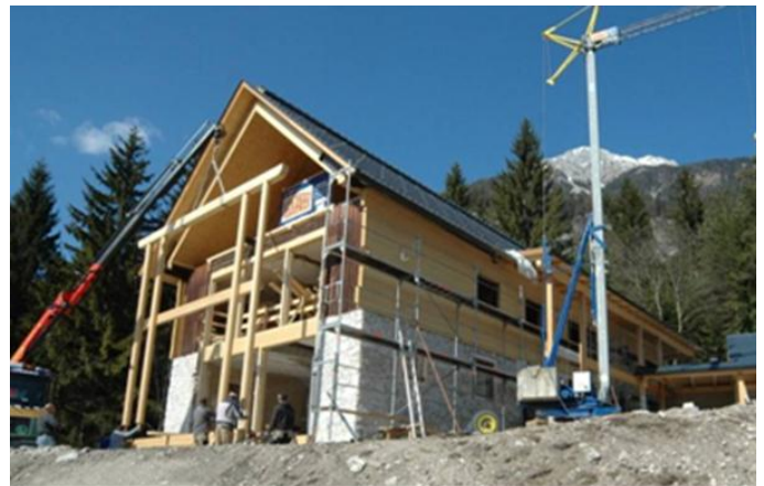
Abbildung 7: Primärkonstruktion Balkon, Holzweichfaserplatten montiert
