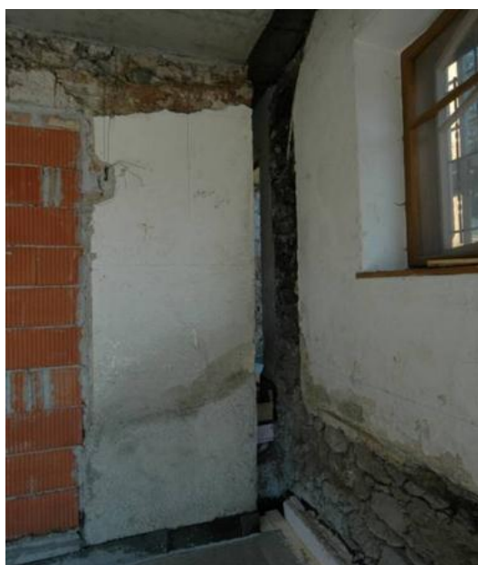
Abbildung 16: Durchtrennung Innen-/Außenwand
